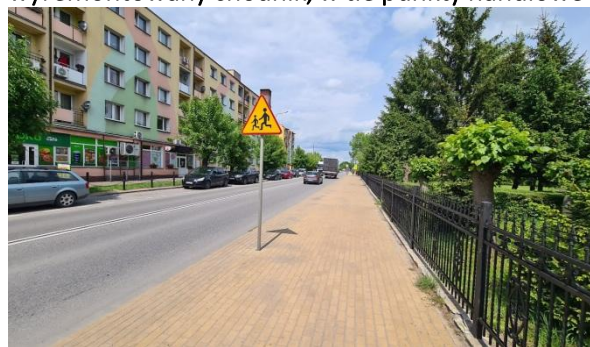
Stan nawierzchni ulicy Zwoleńskiej, wyremontowany chodnik, w tle punkty handlowe
