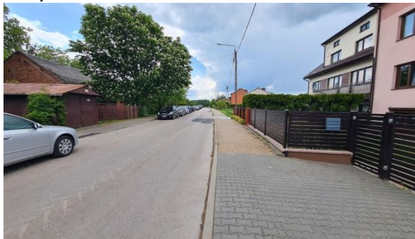
Stan nawierzchni ulicy i chodnika w ciągu ul. Partyzantów
