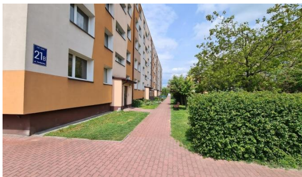
Dojście chodnikiem do klatki schodowej
