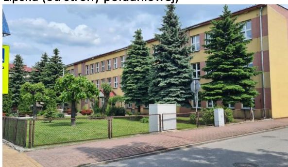
Fragment budynku Publicznej Szkoły Podstawowej im. Antoniego Gustawa Bema w Lipsku (od strony południowej)
