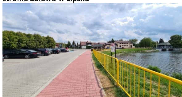
Stan infrastruktury drogowej po północnej stronie Zalewu w Lipsku
