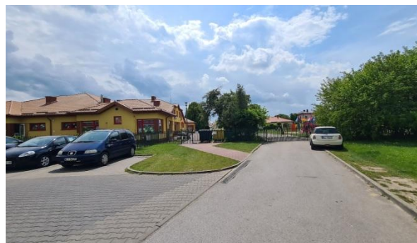
Widok na budynek Przedszkola Samorządowego, na I planie fragment parking
