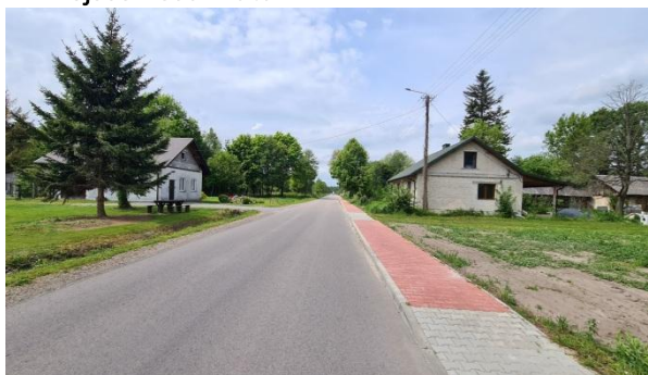
Wyremontowana nawierzchnia drogi i chodnika w miejscowości Huta
